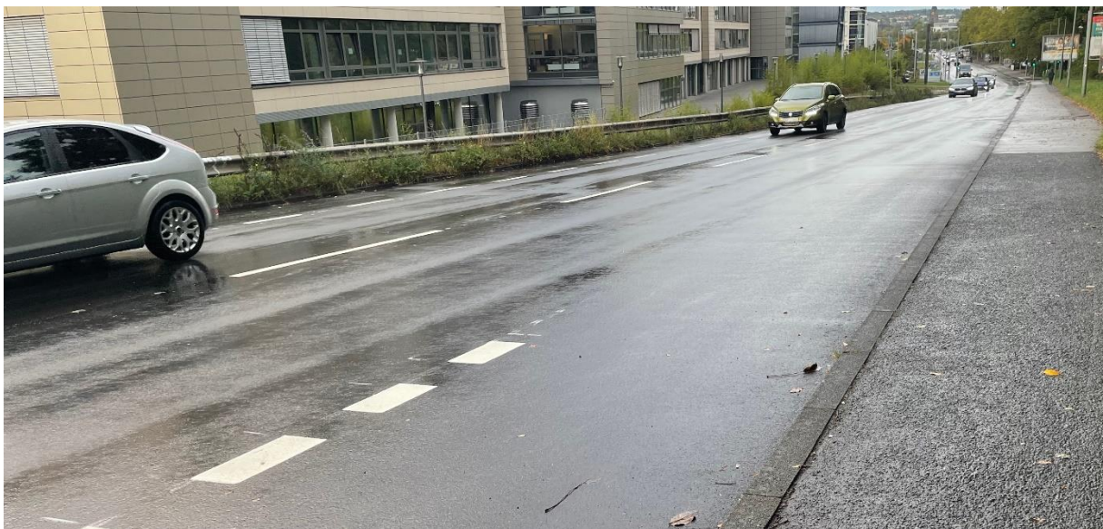
Abbildung 39: Trippstadter Straße mit Blick auf das DFKI (19.10.2023). Schutzstreifen Richtung Norden endet und beginnt erst wieder an der Ampelkreuzung zur Gerhart-Hauptmann-Straße.
