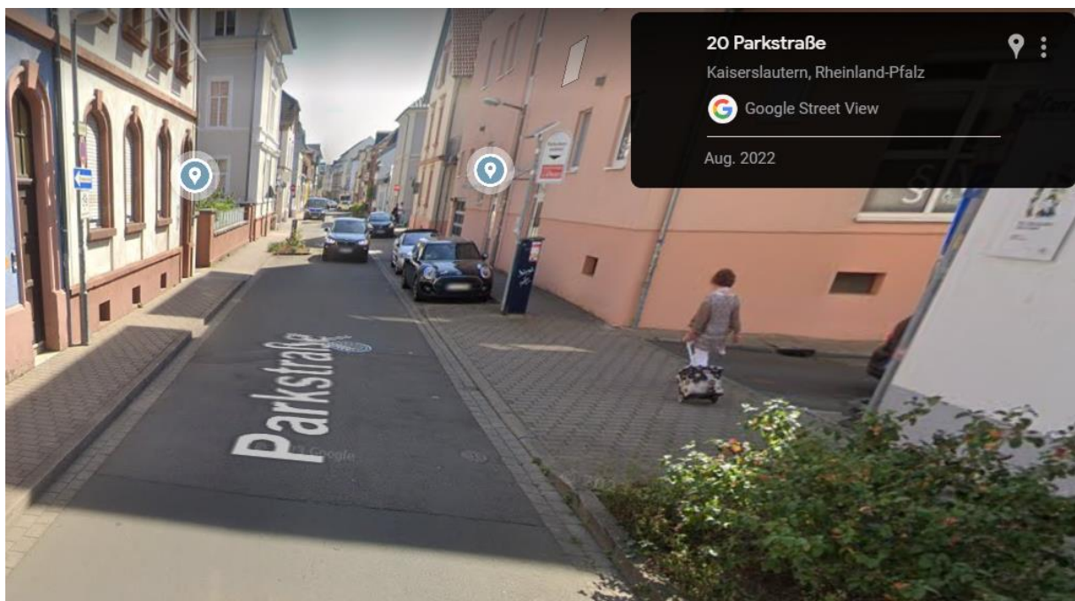
Abbildung 23: Kreuzung Parkstraße/Conradstraße (Google Street View). Schlecht einsehbare Kreuzung, Hindernis links.
