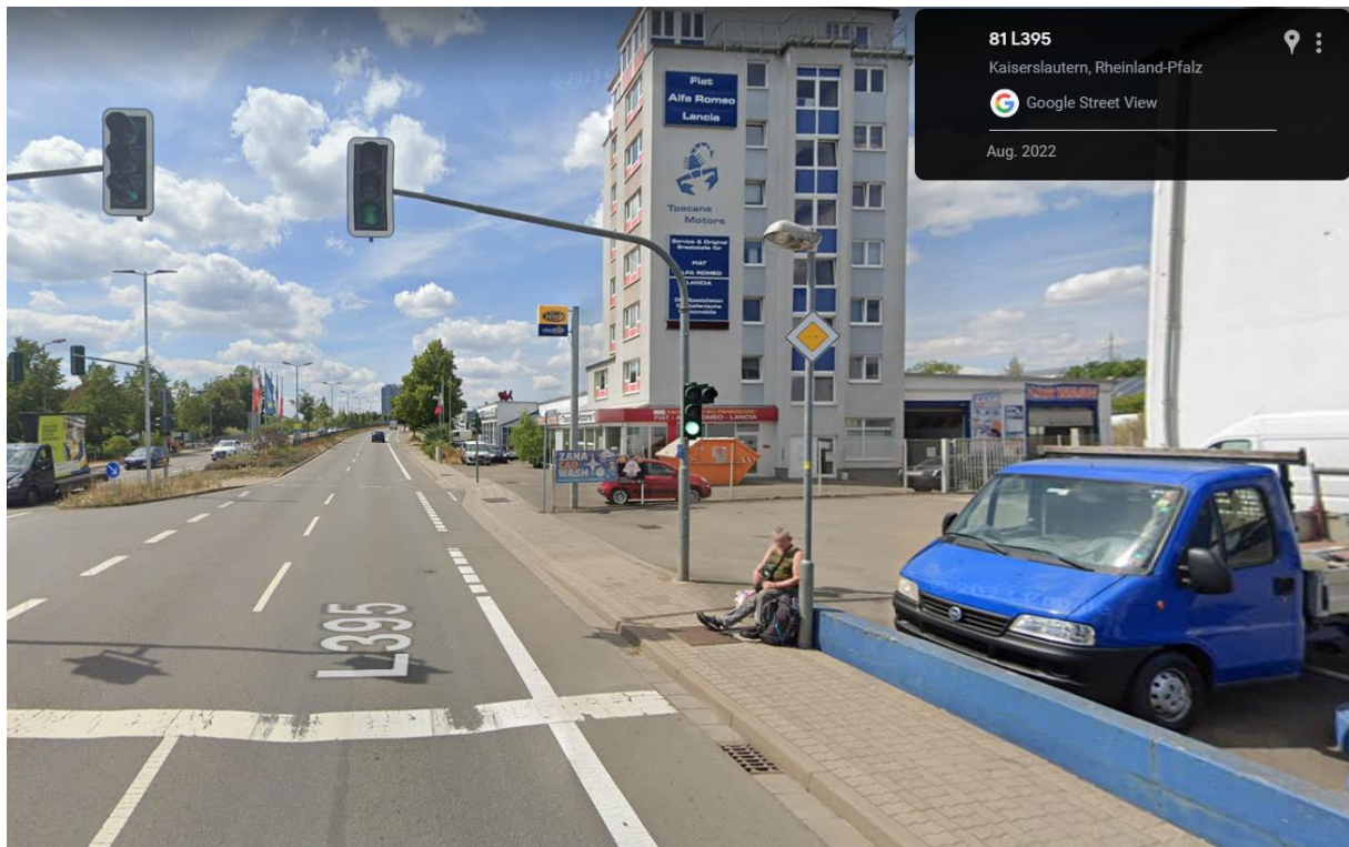
Abbildung 5: Kreuzung Mainzer Straße / Mennonitenstraße (Google Street View). Radfahrstreifen, geht über in Schutzstreifen. Fahrradfahrer müssen an Haltelinie halten, wenn die Ampel rot zeigt. Der Gehweg nebendran ist durchgängig, ohne Ampel.
