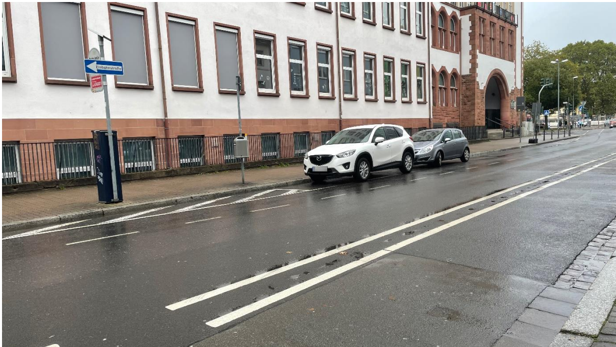
Abbildung 28: Burgstraße auf Höhe des Burggymnasiums (19.10.2023). Richtung Stadtmitte gibt es einen breiten Radfahrstreifen. In Richtung Hochschule gibt es einen Schutzstreifen, der zum Teil neben seitlich an der Straße parkenden Autos verläuft.
