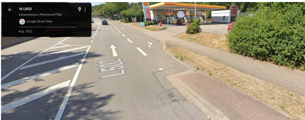
Abbildung 38: Hohenecker Straße auf Höhe der Shell-Tankstelle (Google Street View). Radverkehr wird vom für Radfahrer freigegebenen Gehweg auf die Straße geleitet. Wenige Meter später beginnt versetzt dazu ein Schutzstreifen.
