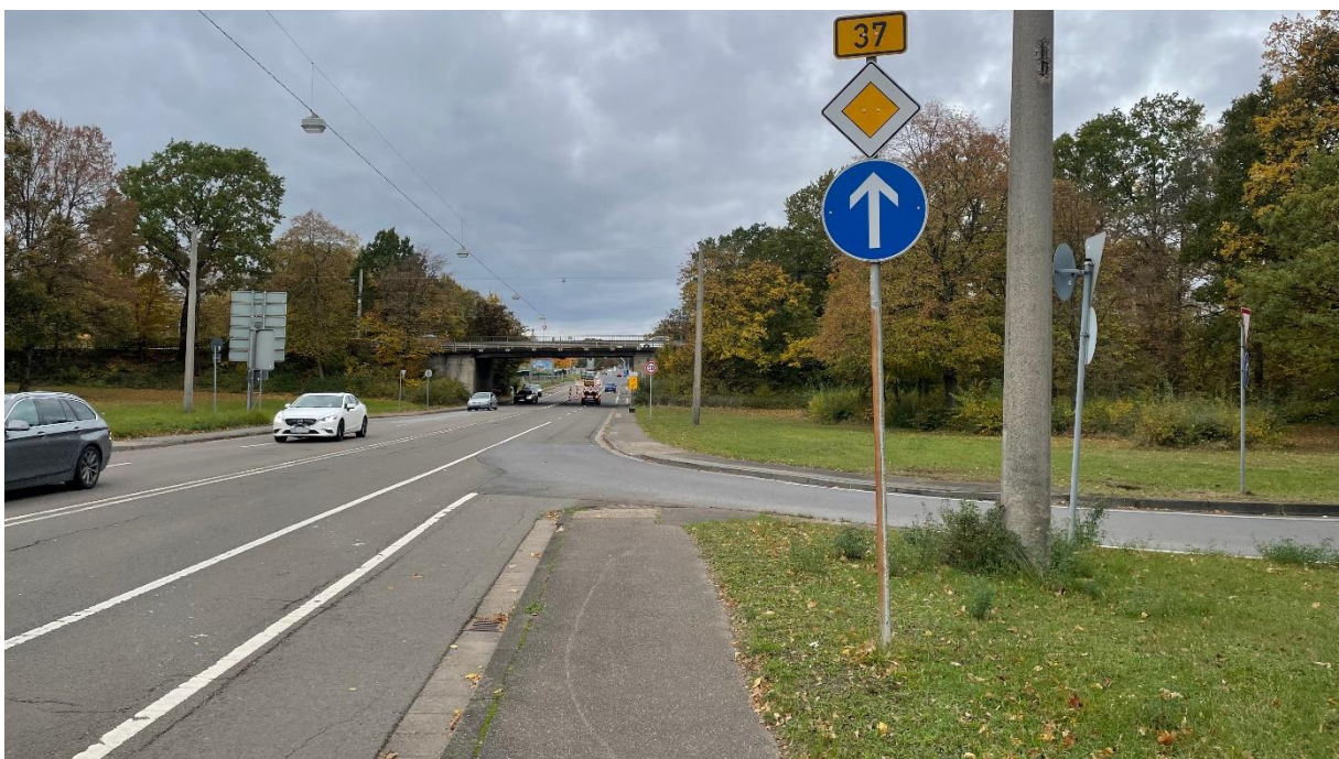
Abbildung 58: Pariser Straße, Abfahrt der B270 (04.11.2023). Fahrradfahrer und Fußgänger müssen Straße überqueren. Auf der anderen Straßenseite gibt es kein Hinweiszeichen für Fahrradfahrer.
