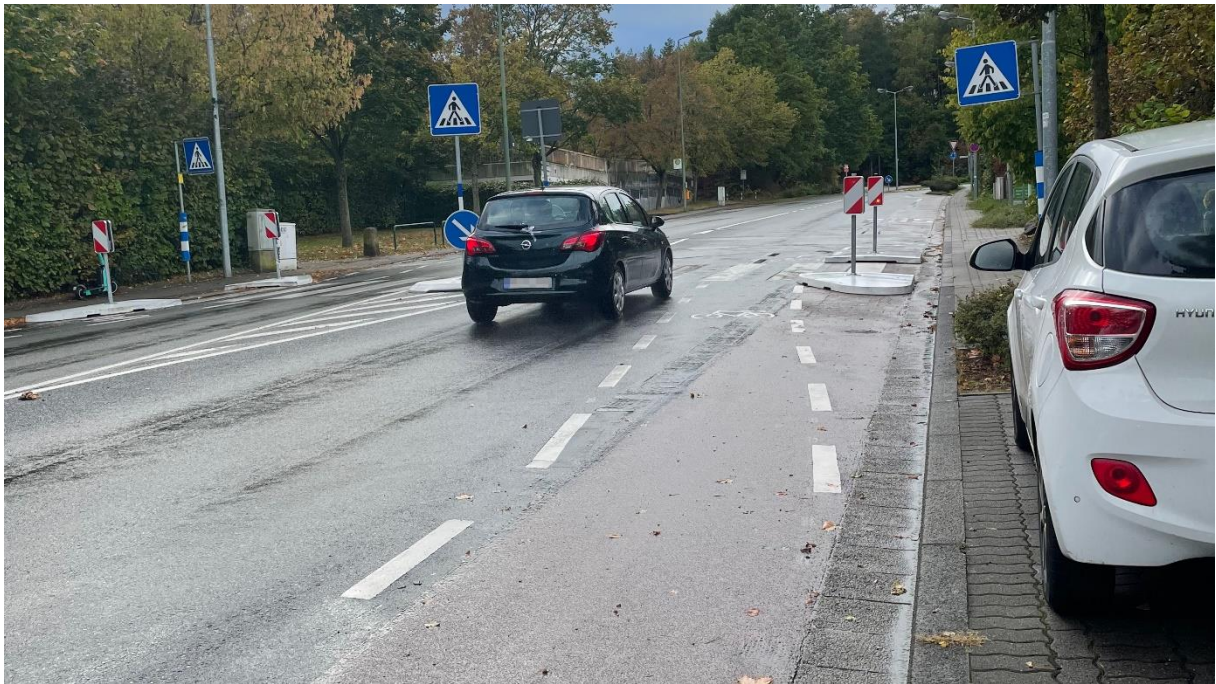
Abbildung 42: Theodor-Heuss-Straße Richtung Westen (19.10.2023). Sicherer Überweg für Fußgänger durch Zebrastreifen und Hindernisse. Gefahrenpotential für Fahrradfahrer durch notwendiges Einschwenken in den Autoverkehr.
