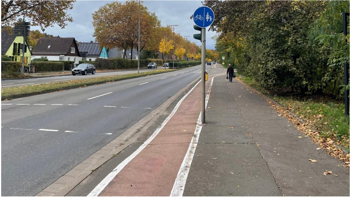
Abbildung 53: Pariser Straße auf Höhe der Haltestelle Bahnheim (04.11.2023). Getrennter Geh- und Radweg.
