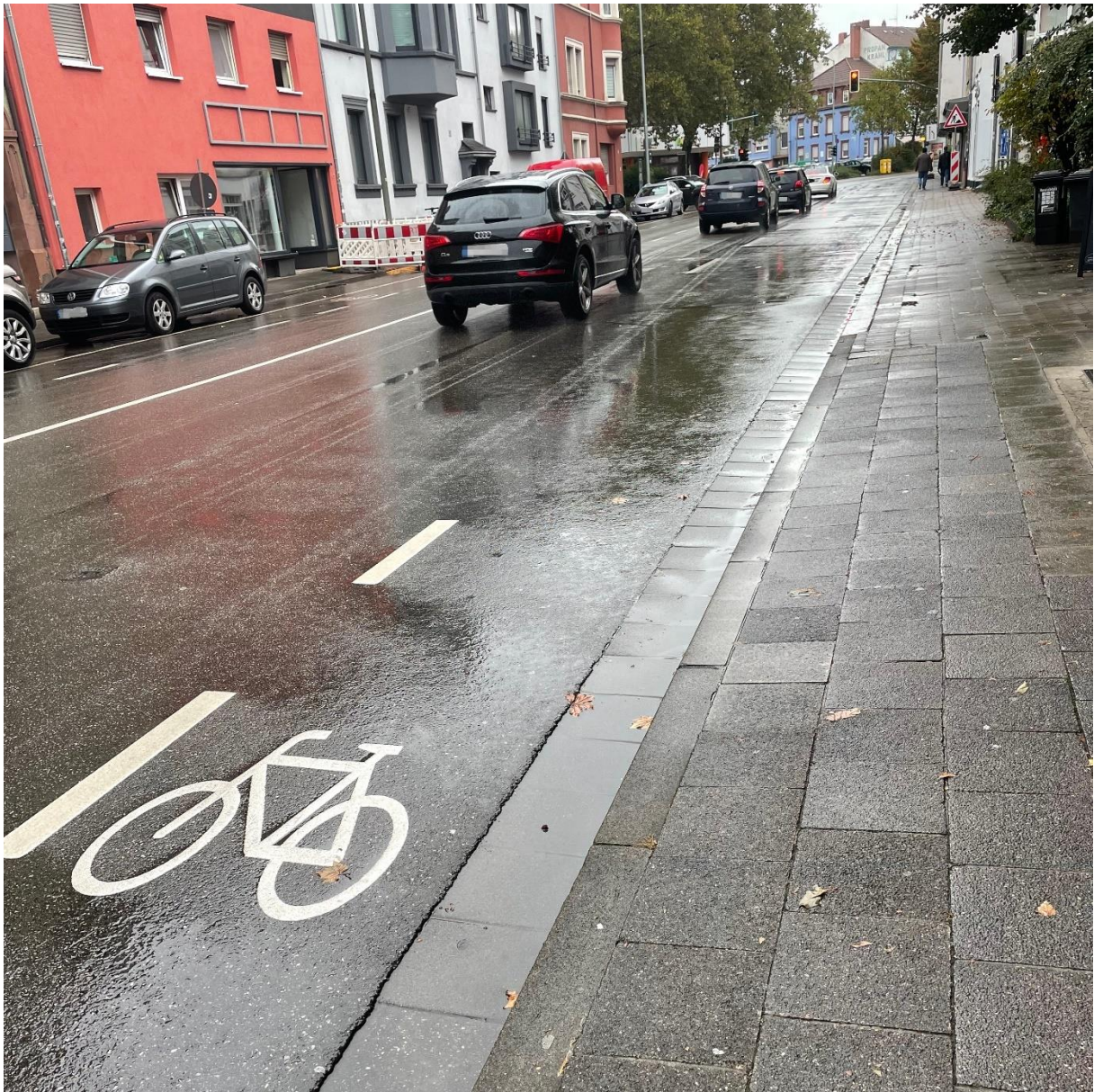
Abbildung 25: Rudolph-Breitscheid-Straße zwischen Marienkirche und Pfaffplatz (19.10.2023). Schutzstreifen in nördliche Richtung endet vor der Kreuzung am Pfaffplatz.
