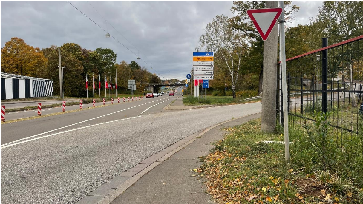
Abbildung 57: Pariser Straße, Auffahrt auf die B270 (04.11.2023). Fahrradfahrer und Fußgänger müssen Auffahrt überqueren.
